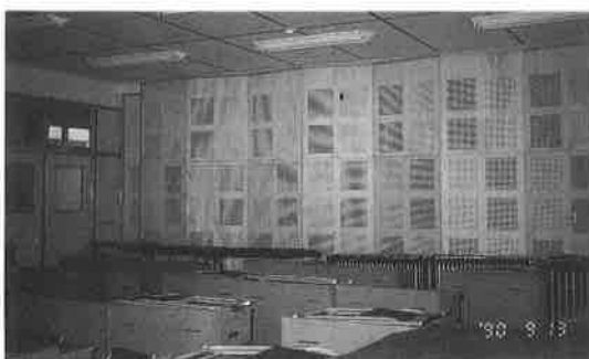
音楽室(旧図工室)の吸音壁
