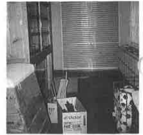
グラウンド側に新設された器具室 (旧更衣室)
