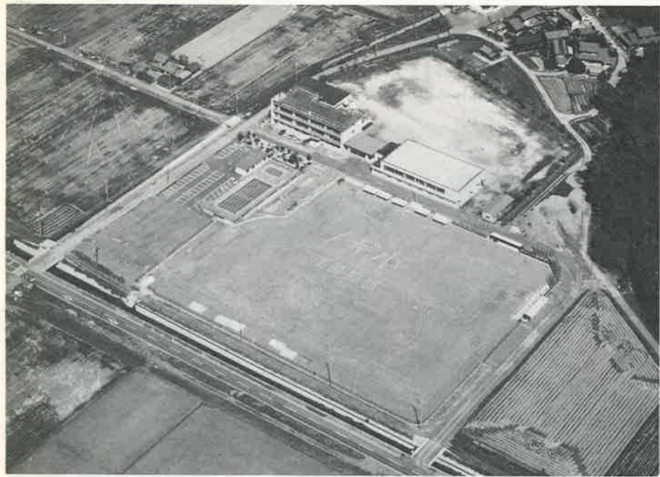
野木小学校全景 新グラウンド完成
