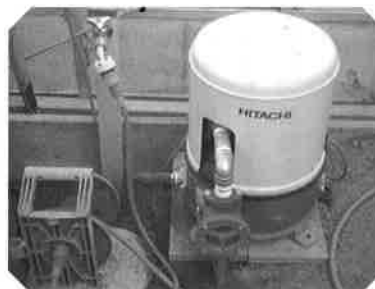
● 掘り抜きポンプ一式
